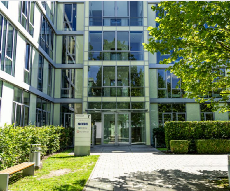
HAUSEINGANG HAUS NR. 7
